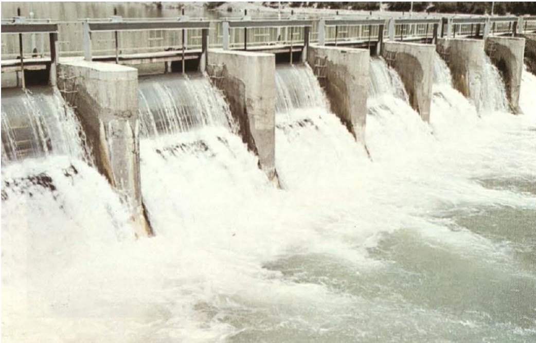
Figure A.5. Tortum Hydroelectric Facilities Gölayağı Weir (source: İller Bankası'nın 67 Yılı (İller Bankası Genel Müdürlüğü))
