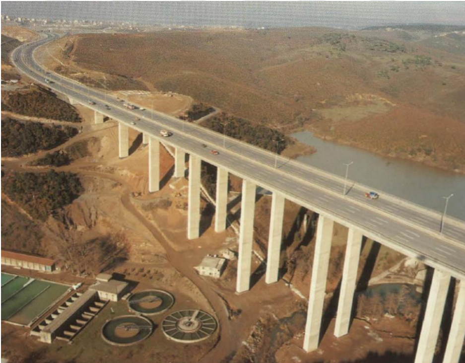
Figure A.11. Anatolian Motorway Elmalı Viaduct (source: Cumhuriyetin 70. Yılında Bayındırlık ve İskan Bakanlığı (T.C. Bayındırlık ve İskan Bakanlığı, 1993))
