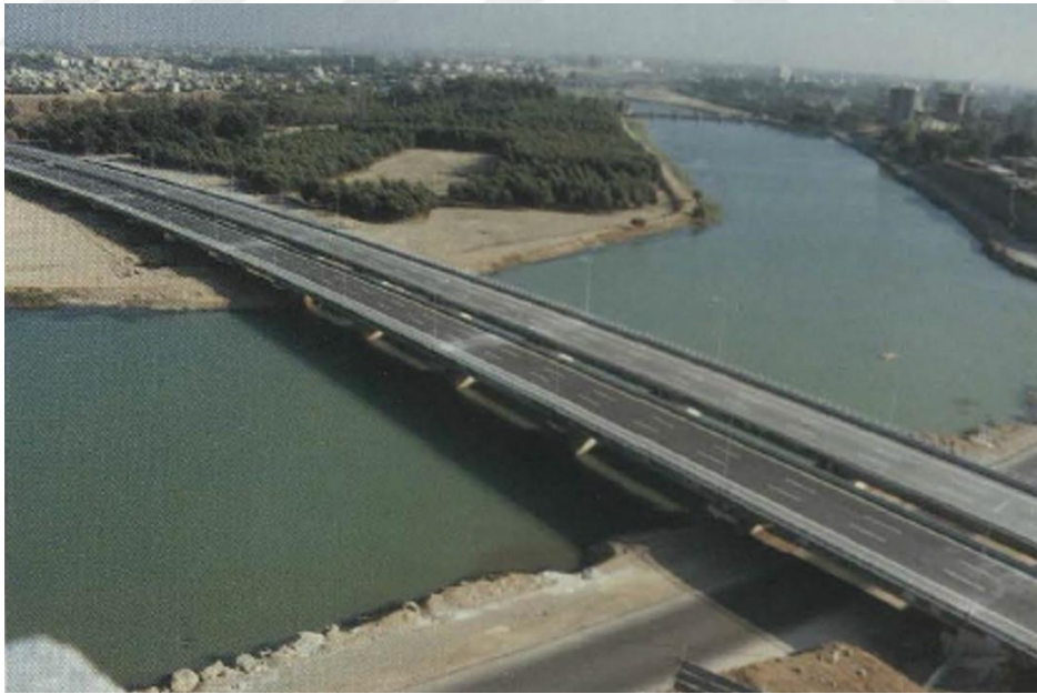
Figure A.15. A view of the Tarsus - Gaziantep Motorway from the Adana-Seyhan Bridge (source: Cumhuriyetin 70. Yılında Bayındırlık ve İskan Bakanlığı (T.C. Bayındırlık ve İskan Bakanlığı, 1993))
