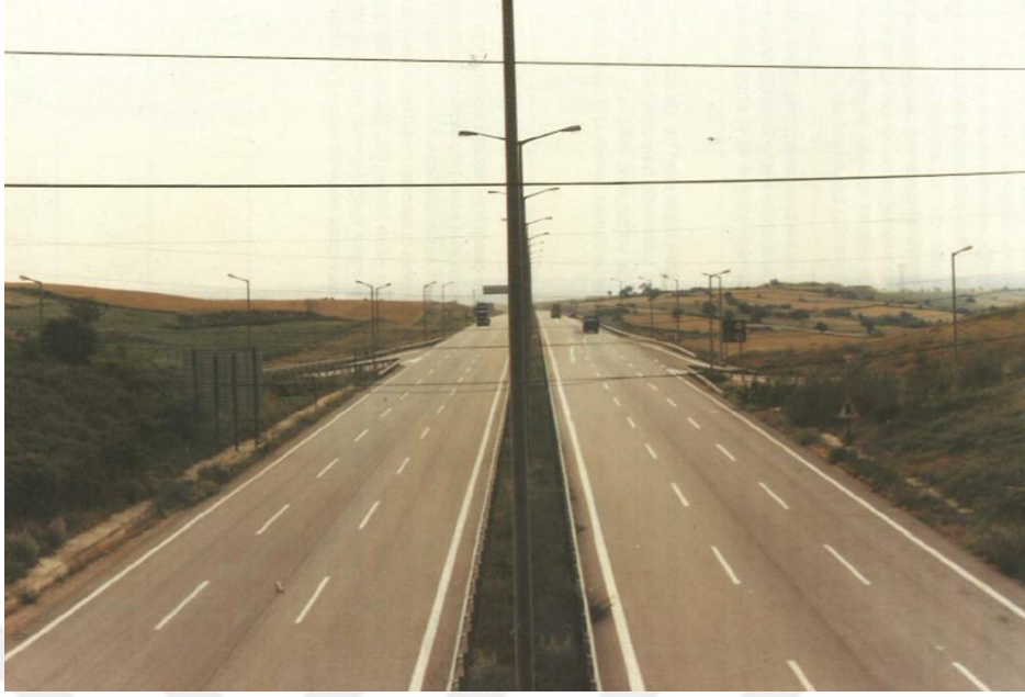
Figure A.14. Trakya Motorway Edirne – Kınalı Section (source: Cumhuriyetin 70. Yılında Bayındırlık ve İskan Bakanlığı (T.C. Bayındırlık ve İskan Bakanlığı, 1993))
