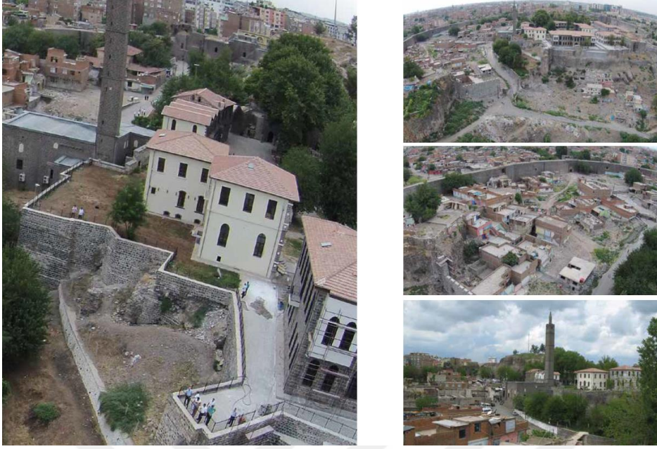
Figure B. 21. Diyarbakır Sur İçkale Valley Landscaping (before) (source: Proje Uygulamaları 2016-2017: Diyarbakır Sur İçkale Vadisi Çevre Düzenlemesi (T.C. Başbakanlık Toplu Konut İdaresi Başkanlığı))
